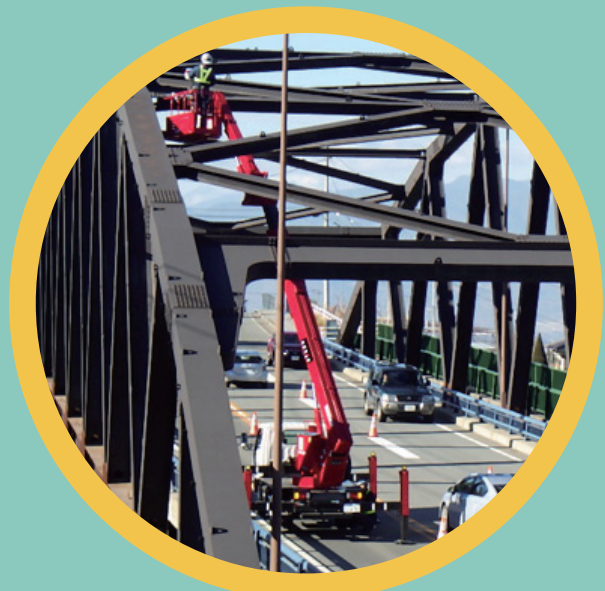
新十郎橋 笛吹市御坂町地内
